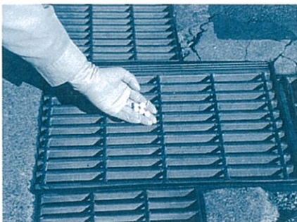
雨水マスに処理！
