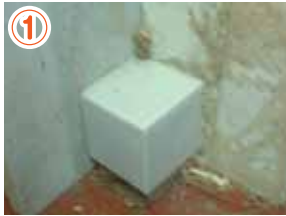
① 蟻道に沿ってボックスを設置する
